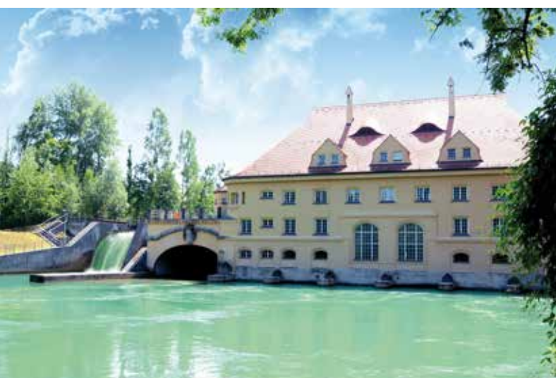
Wasserkraftwerk Isar 1 in München
